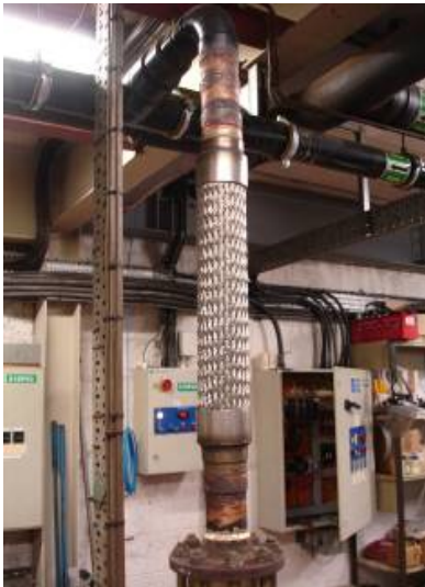
Dispositif anti vibratoire mal installé
