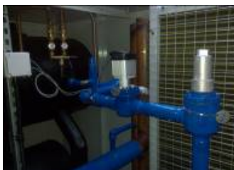
Vanne d'arrêt avec capuchon à droite et actuateur motoriser à gauche
