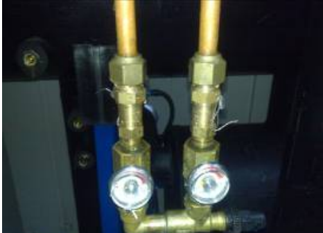
Exemple de bonne pratique de raccordement
