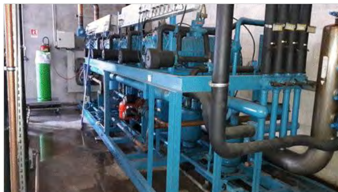
Figure 5 – Bouteille de transfert installée sur balance et reliée à l'installation frigorifique de l'entrepôt A par un flexible de récupération.
