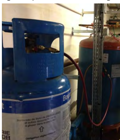
Figure 10 - Essai Système expert SE 2 sur installation frigorifique de l'hypermarché A avec réservoir vertical
