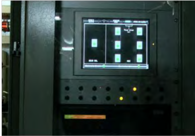
Figure 22 – Ecran de contrôle des 6 groupes et du réservoir
