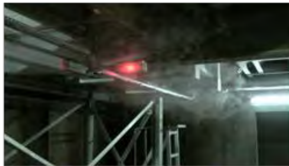
Figure 29 – écoulement fumigène vers la bouche d'aération, sous le caillebotis
