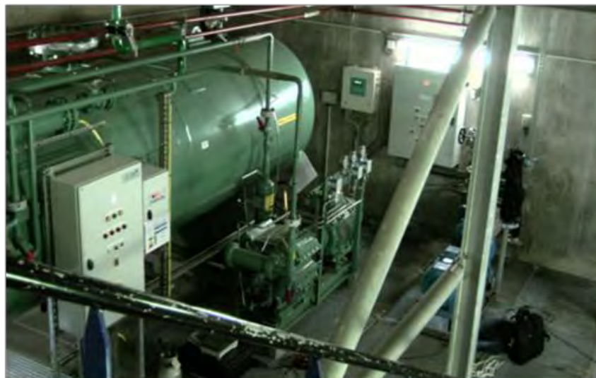
Figure 25 – Première zone d'essai : réserve sur caillebotis
