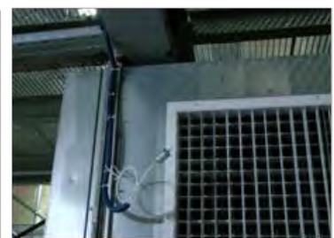
S6: Sonde N°6 sur la gaine d'extraction d'air incendie
