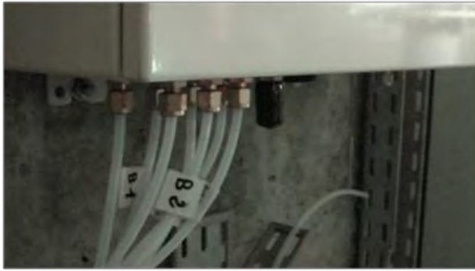
Figure 26 – tubes d'aspiration reliant les sondes au contrôleur
