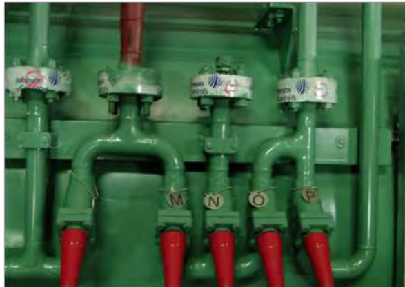
Figure 20 – Maintenance préventive au niveau des soupapes
