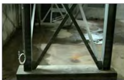
Sonde N°7 - Sous caillebotis position sol près du mur
