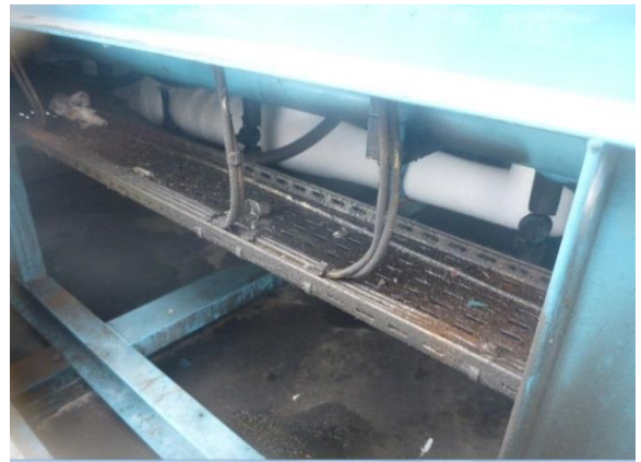
FIGURE 19. PRESENCE D'HUILE SUR LE SOL
