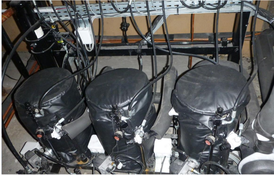
FIGURE 22. PRESENCE SYSTEMATIQUES DE FLEXIBLE
