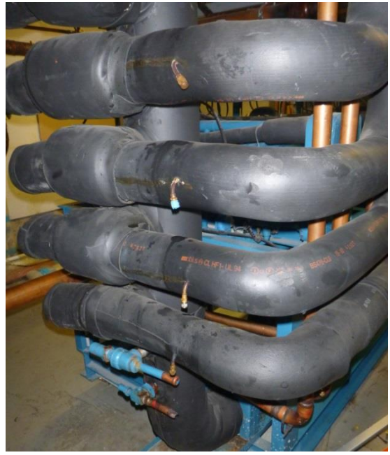
FIGURE 16 : EXEMPLE DE CENTRALE DE COMPRESSION COMPRENANT DE NOMBREUSES PRISES DE PRESSION
