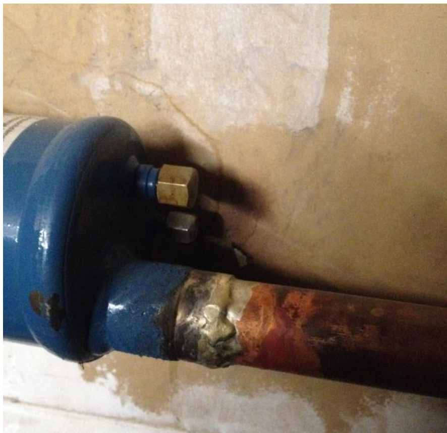
FIGURE 21. EXEMPLE DE SOUDURE MAL REALISEE
