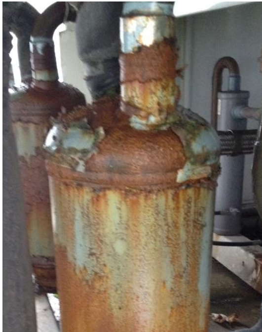
FIGURE 17. EXEMPLE DE CORROSION AVANCEE SUR UN RESERVOIR D'ASPIRATION SITUÉ EN EXTERIEUR
