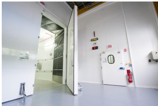
Figure 13-7 : Tunnel climatique d'essai pour groupe frigorifique de transport
