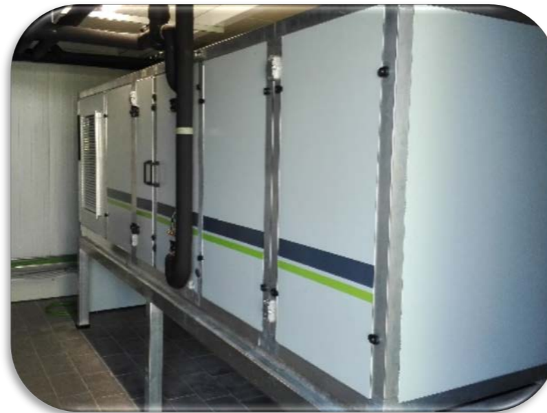
CTA 2 dédiée pour la Climatisation
