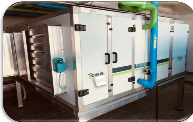
CTA 1 dédiée pour la Climatisation
