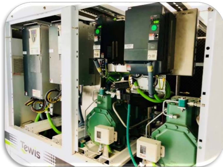
Variateurs de la centrale frigo
